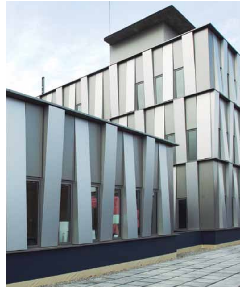
Edifici GAIA - Parc UPC. © UPC.
