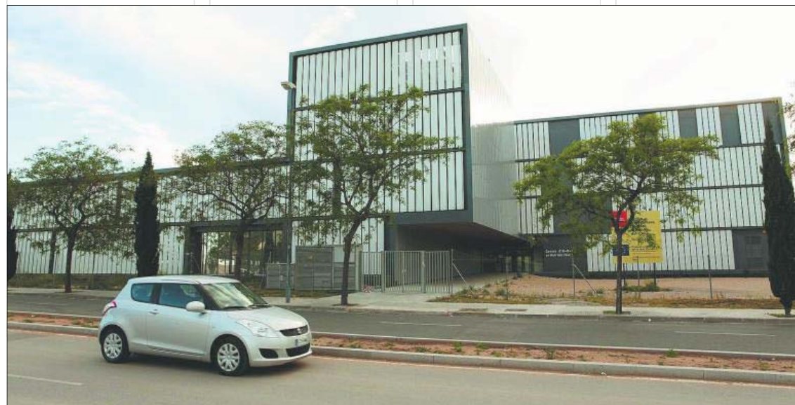
Imatge de l'edifici que acull les instal·lacions de l'Institut d'Investigació Sanitària Pere Virgili. FOTO: A. MARINÉ
